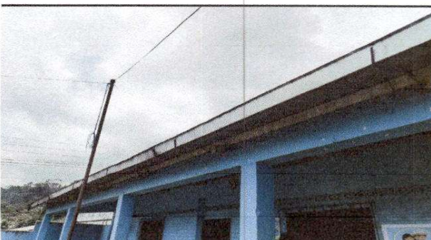
FOTO 4: Sustitución de canal de metal aluzinc calibre 26
